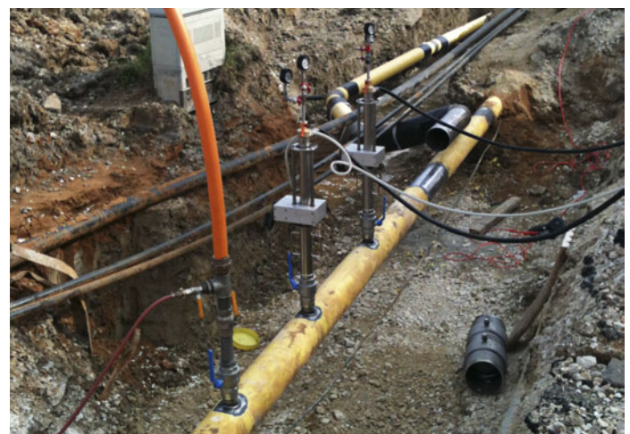
Von dem PTB begleitete Baustelle
