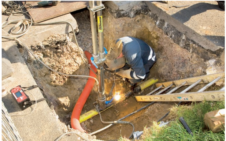
Aufschweißen eines Reparaturflickens zum Verschließen des Lochs, welches die Anschlussschelle hinterläßt. (Beim Schweißvorgang sind die Absperrblasen bereits gezogen.)
