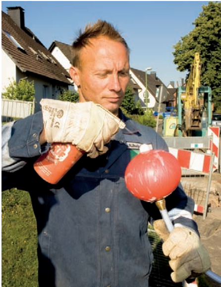
Abseifen einer MDS-Absperrblase mit Lecksuchmittel
