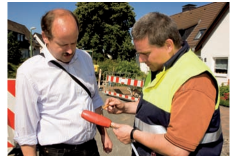
Vor jedem Einsatz muss die Dichtigkeit und der optische Zustand der Blase geprüft werden!
